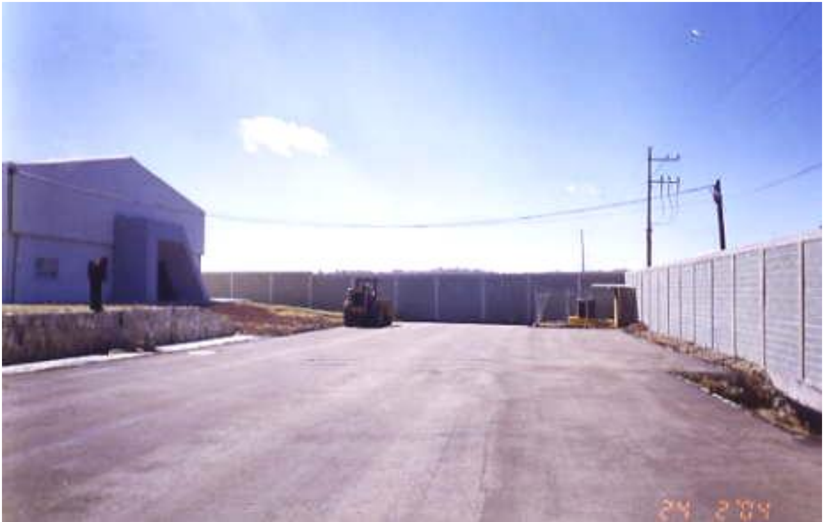
TENDIDO Y COMPACTACION DE CARPETA ASFALTICA EN FRIO
