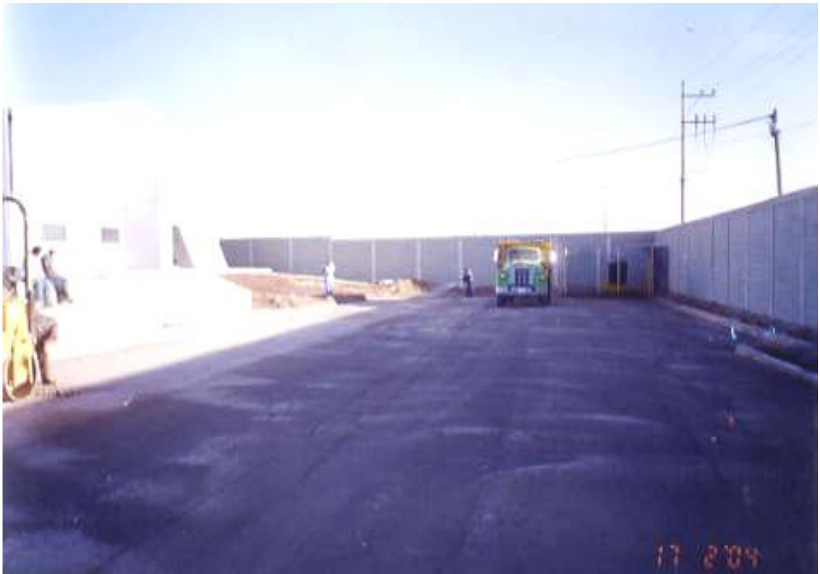
HUMECTACION DE BASE HIDRÁULICA CON MULTIMOVIL MIXER
