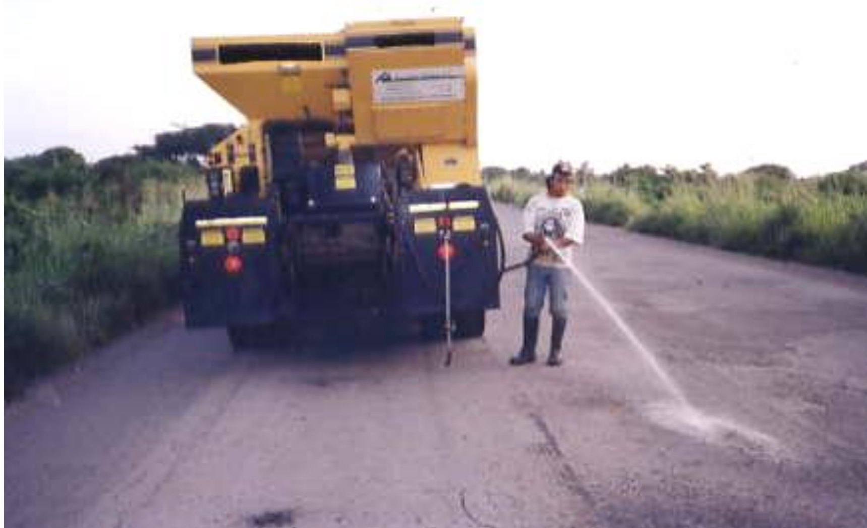
LIMPIEZA Y RIEGO DE LIGA EN LA ZONA POR REPARAR
