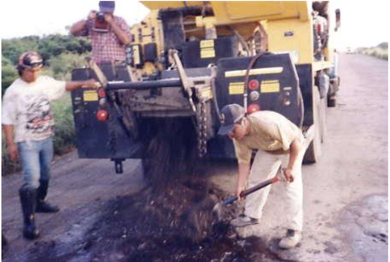
PRODUCCION DE MEZCLA ASFALTICA MEDIANTE ESTABILIZADORA VIAJERA
