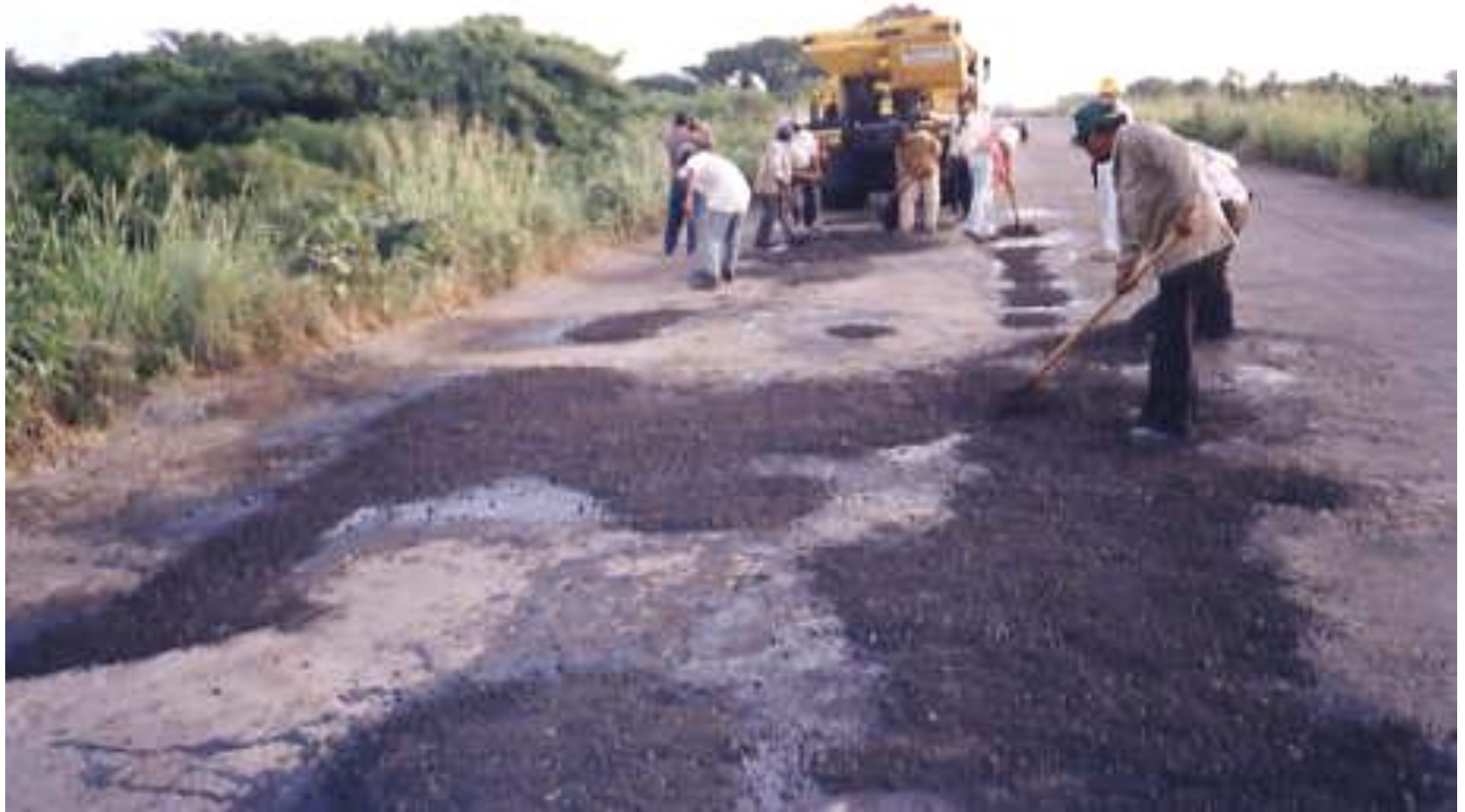
COLOCACION Y COMPACTACION DE LA MEZCLA
