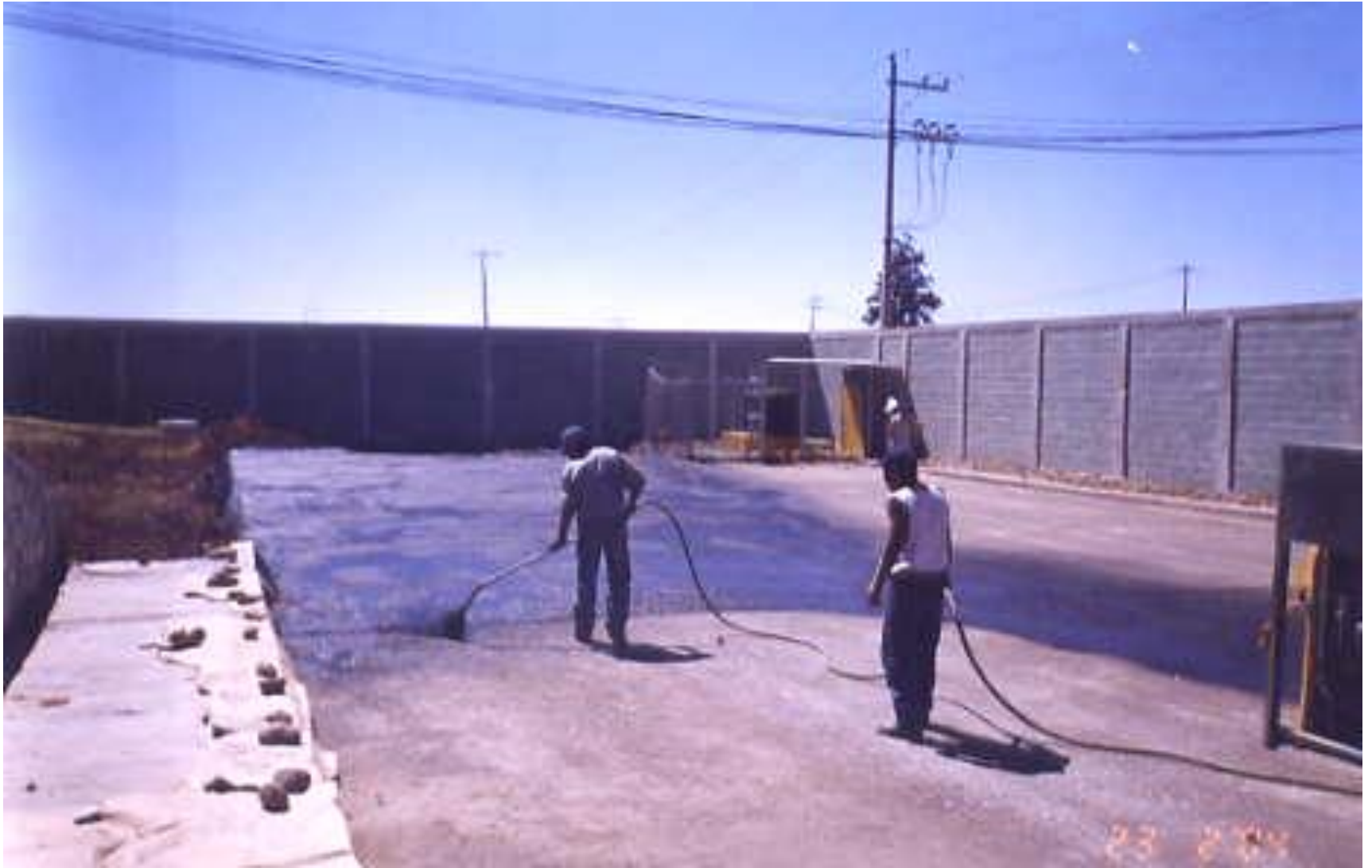
ELABORACION DE CARPETA ASFALTICA CON MULTI MOVIL MIXER
