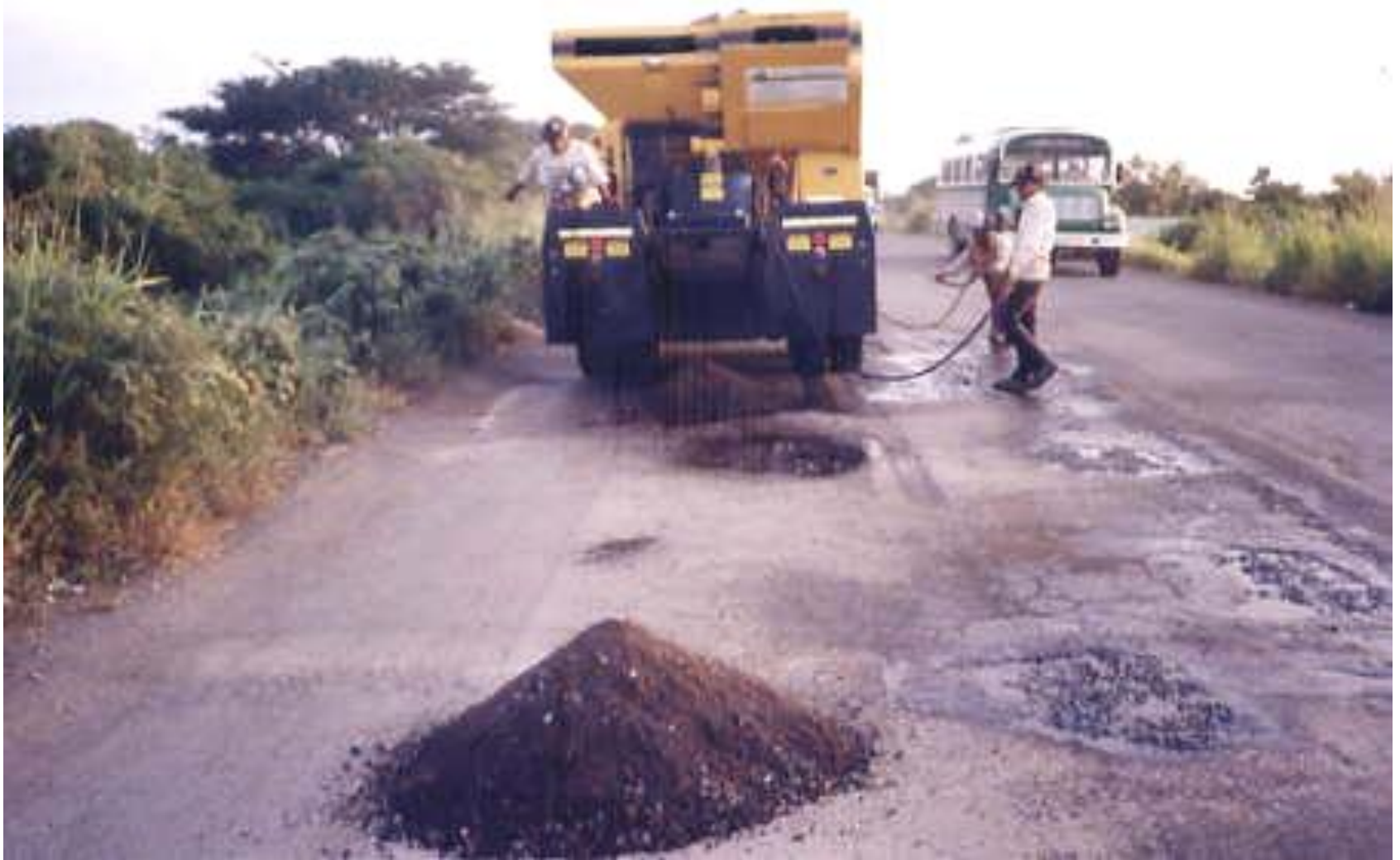
PRODUCCION DE MEZCLA ASFALTICA MEDIANTE ESTABILIZADORA VIAJERA
