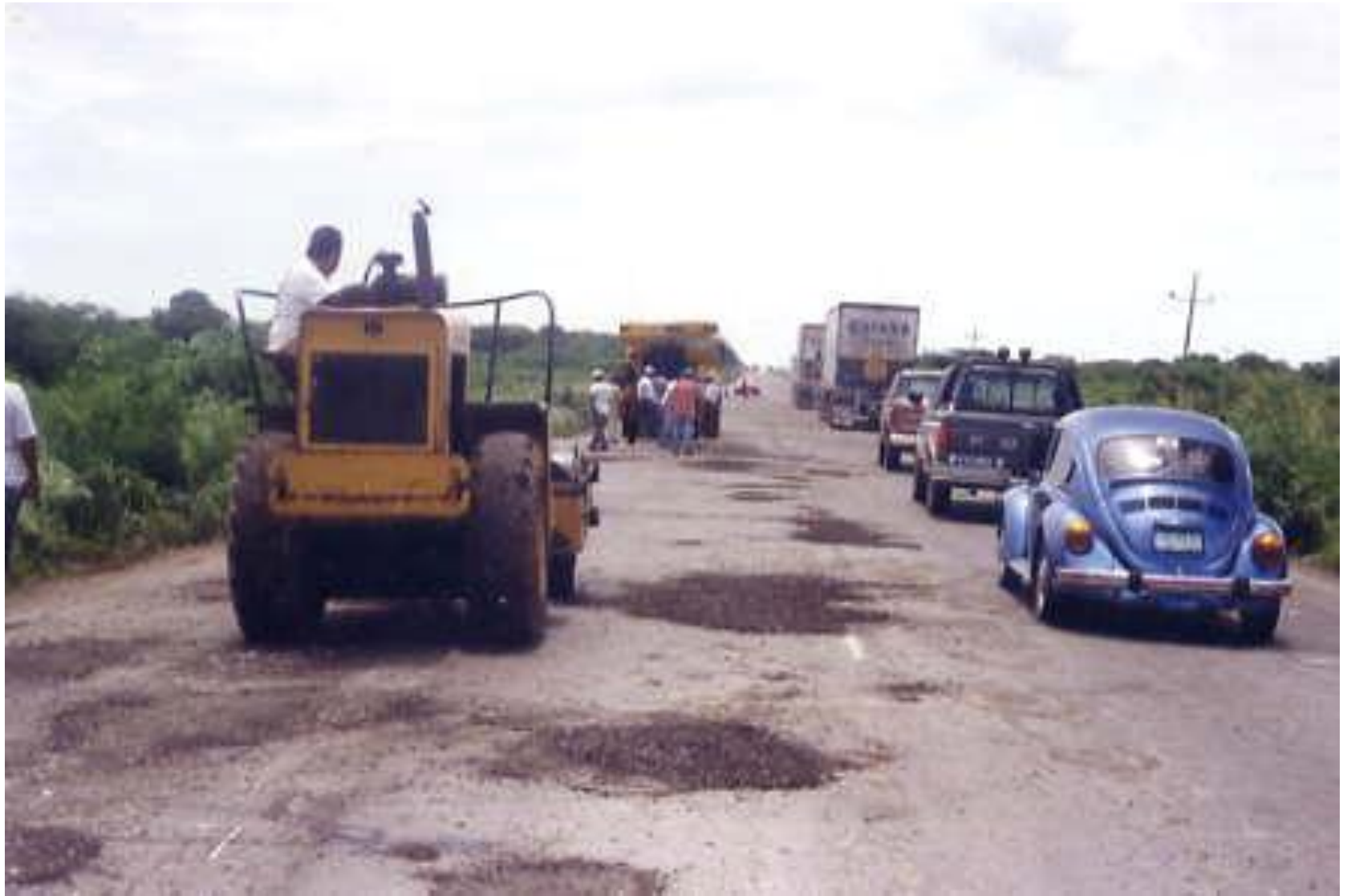
COLOCACION Y COMPACTACION DE LA MEZCLA
