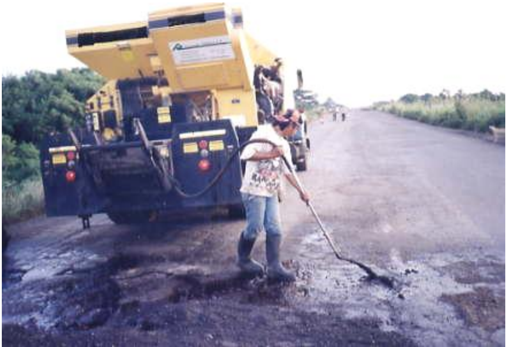
LIMPIEZA Y RIEGO DE LIGA EN LA ZONA POR REPARAR
