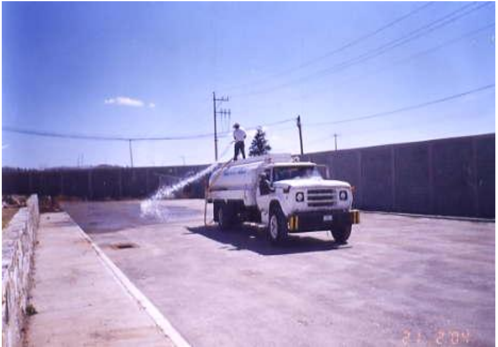
HUMECTACION DE BASE HIDRÁULICA CON MULTIMOVIL MIXER
