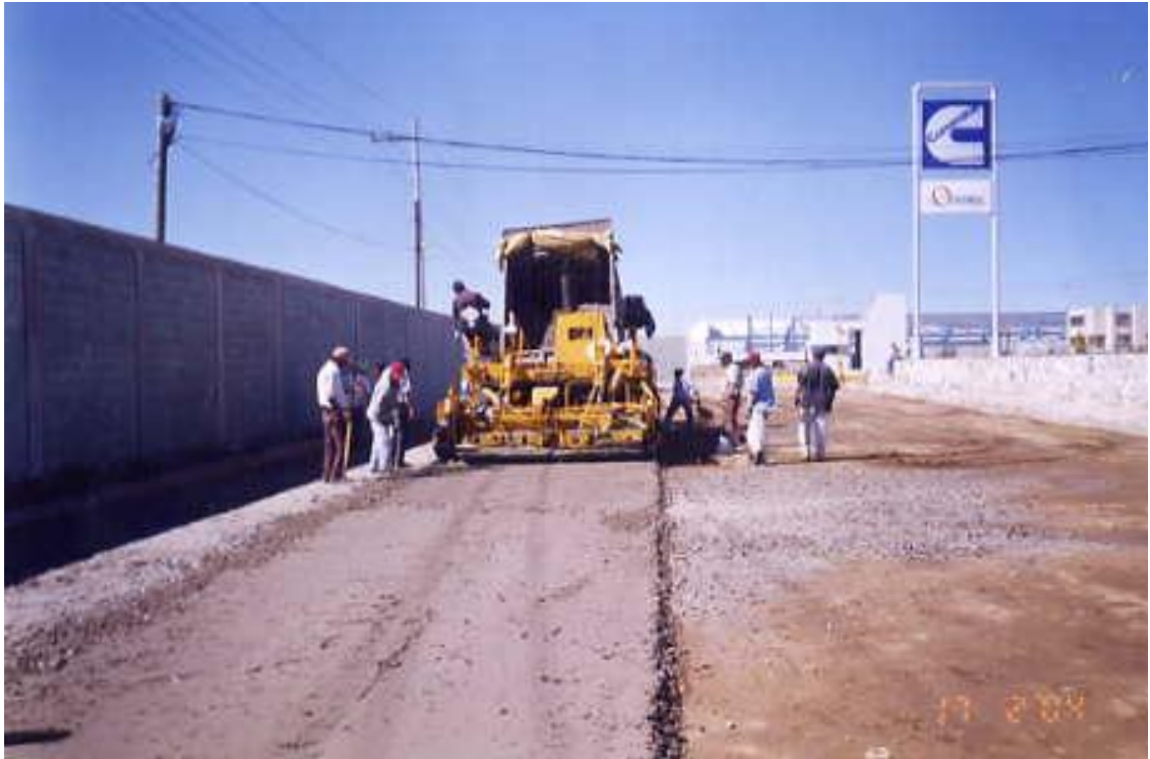
TENDIDO DE BASE HIDRÁULICA CON EXTENDEDORA FINISHER
