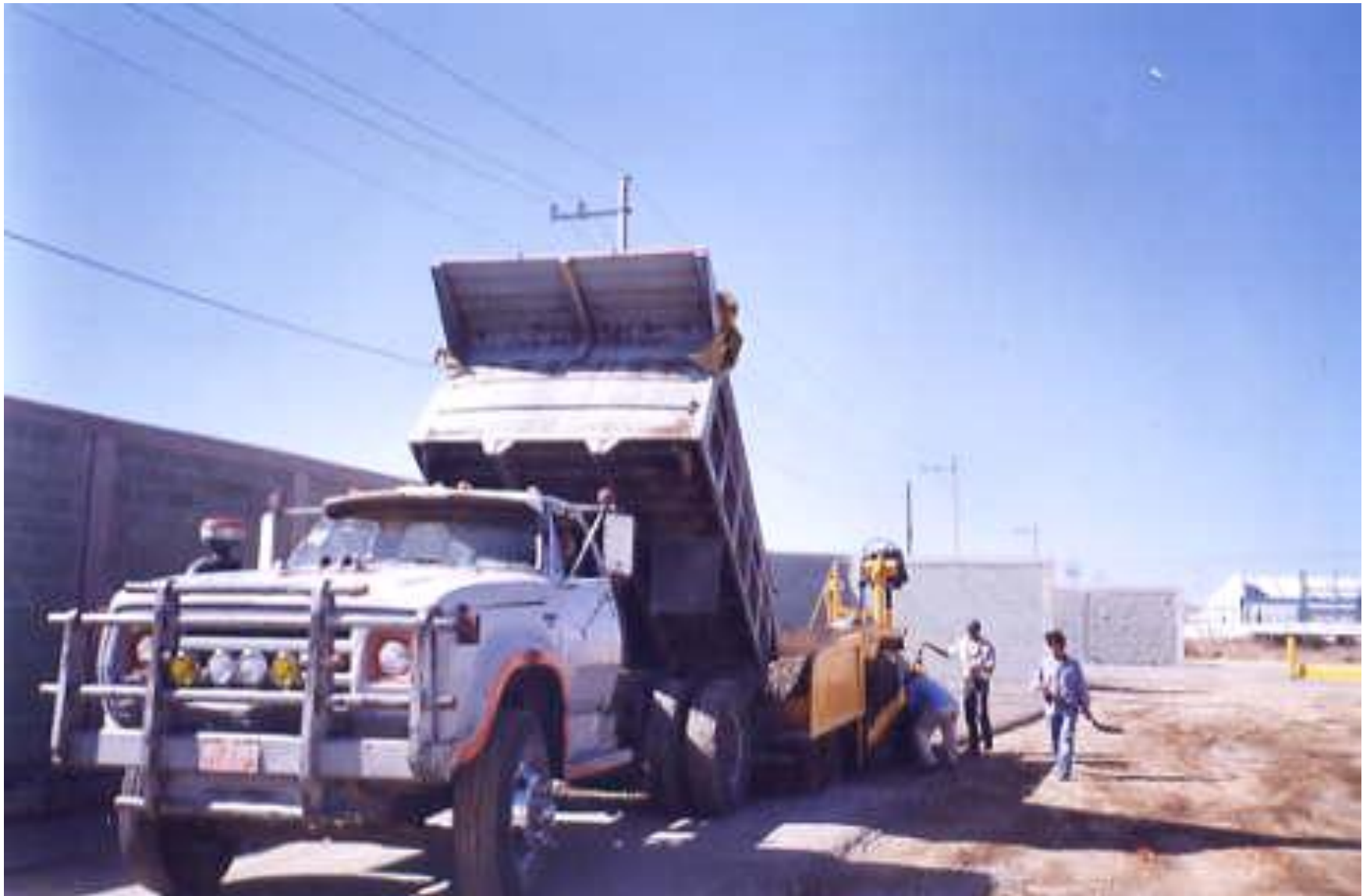
TENDIDO DE BASE HIDRÁULICA CON EXTENDEDORA FINISHER
